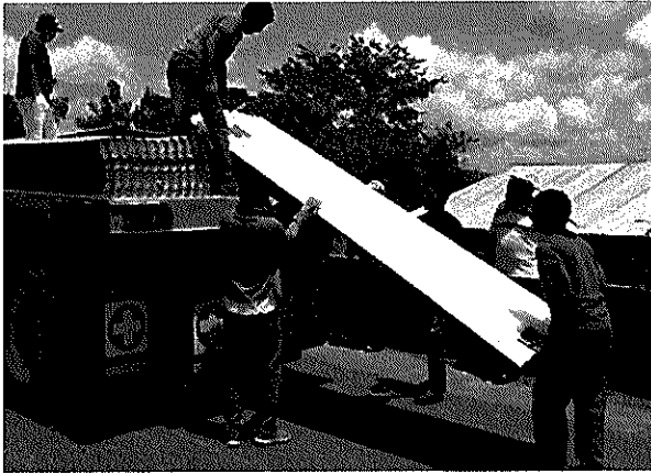
Rehabilitación de techo firme, Ranchería la Florida.
