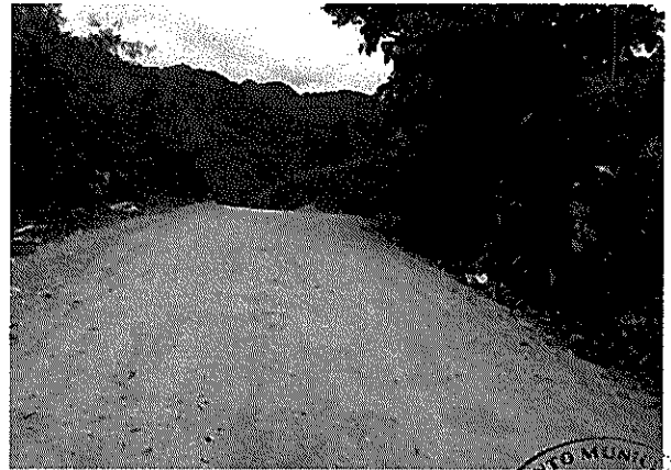
Revestimiento de Camino Sacacosecha, Ejido San Antonio Porvenir.
