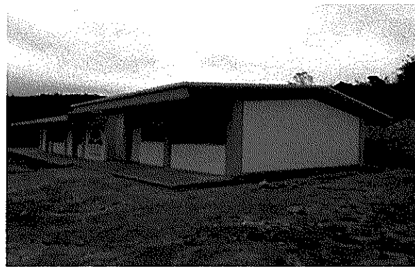
Construcción de un aula didáctica EST.U-1C DE 2 E.E de 3.24x8mts.en Telebachillerato comunitario no. 39 "Benito Juárez García". Con clave: 07ETK0083F, Ejido Ojo de Agua
