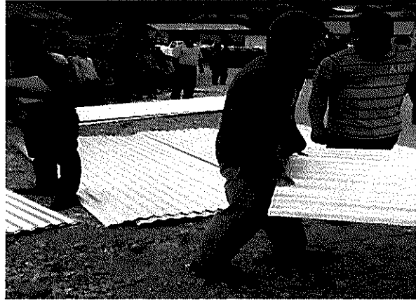
Rehabilitación de techo firme, Ejido Santa Rita el vergel
