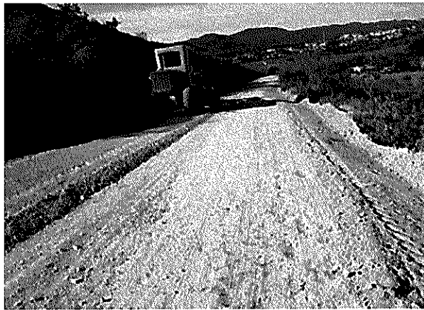
Apertura y Revestimiento de camino, La Independencia.
