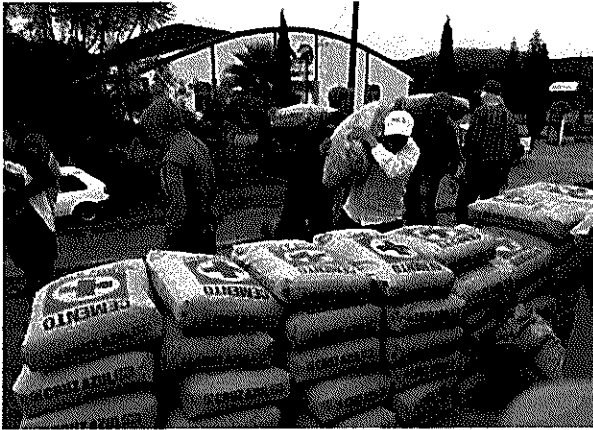
Construcción de piso firme, La Independencia
