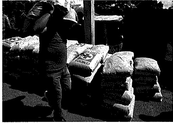
Construcción de piso firme, Ejido Venustiano Carranza
