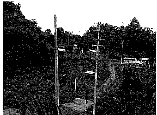
Construcción de Línea de distribución de energía eléctrica, Ranchería Santa María.
