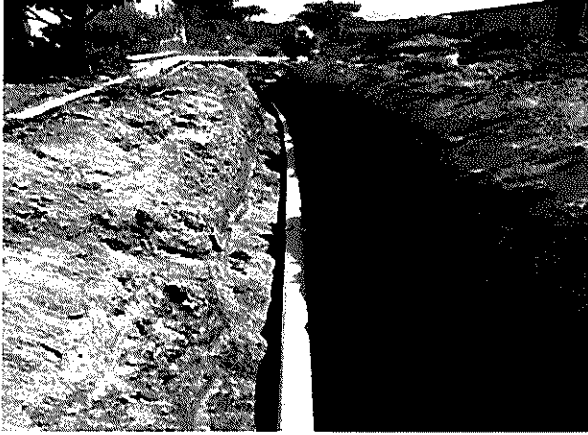
Rehabilitación de la red de distribución de agua potable. La Independencia
