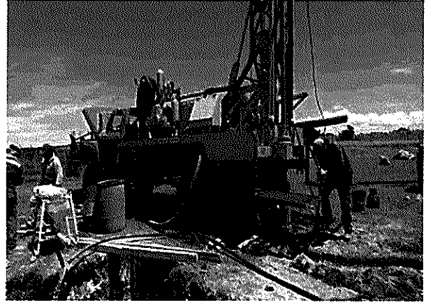
Perforación de Pozo profundo. Ejido Fco. Sarabia
