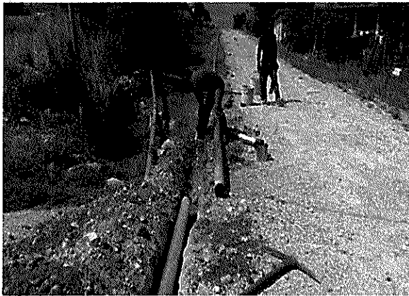
Rehabilitación de la red de distribución de agua potable. Anexo Buena Vista
